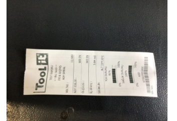
Elektrik donanımı/Pano, Akü > Test Sonucu
