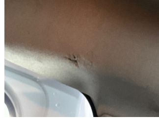
Döşemeler/Kapaklar, Tavan döşemesi > Hasarlı
