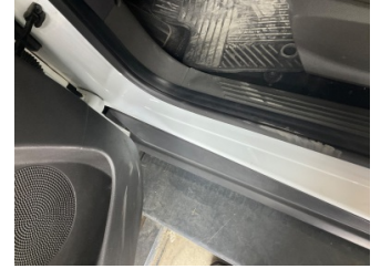
Döşemeler/Kapaklar, Döşemeler/Kapaklar > Çizik
