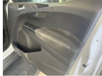
Döşemeler/Kapaklar, Döşemeler/Kapaklar > Kirlenmiş
