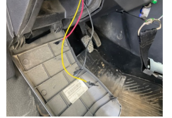
Elektrik donanımı/Pano, Kablo demeti > Standart Dışı Onarım
