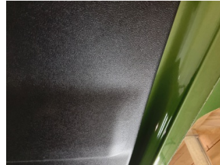
Döşemeler/Kapaklar, Döşemeler/Kapaklar > Çizik
