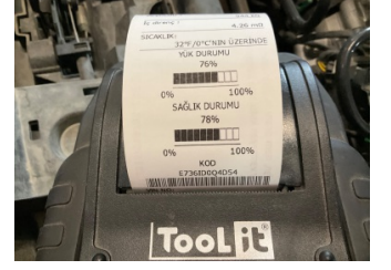
Elektrik donanımı/Pano, Akü > Test Sonucu
