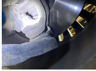
Direksiyon sistemi, Rot kolu/Rot başı, sağ > Hasarlı
