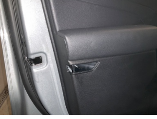
Döşemeler/Kapaklar, Kapı döşemesi, sol ön > Eksik
