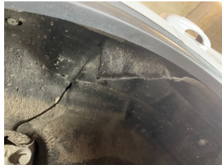
Çamurluk, sağ arka, Davlumbaz > Sabitlemesi Hatalı
