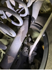
Arka aks, Amortisör, arka > Yağ Kaçağı
