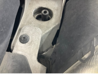
Kaporta, Ön Panel > Standart Dışı Onarım
