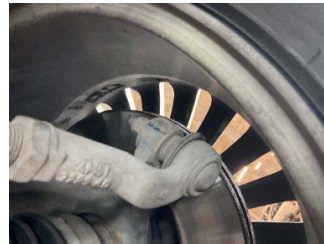
Direksiyon sistemi, Rot kolu/Rot başı, sağ > Hasarlı
