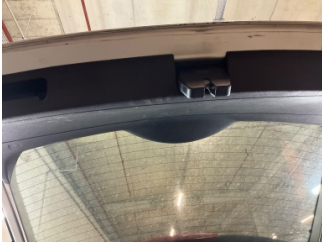
Döşemeler/Kapaklar, Döşemeler/Kapaklar > Çizik
