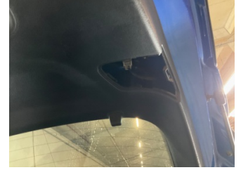
Döşemeler/Kapaklar, Bagaj kapağı, iç döşemesi > Eksik
