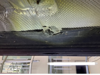
Kaporta, Muhafaza, orta > Hasarlı
