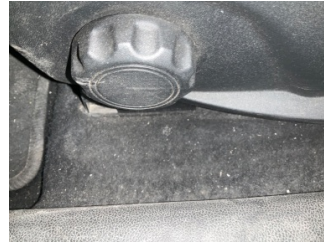
Döşemeler/Kapaklar, Döşemeler/Kapaklar > Yakıcı Madde Ile Zarar Görmüş
