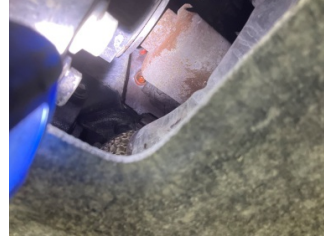
Motorsoğutması, Soğutma sıvısı > Sızdırıyor
