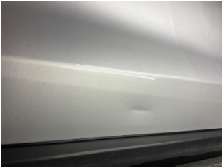
Kapı, sol ön, Kapı, sol ön > Ezik
