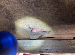
Motor, Alt muhafaza > Hasarlı
