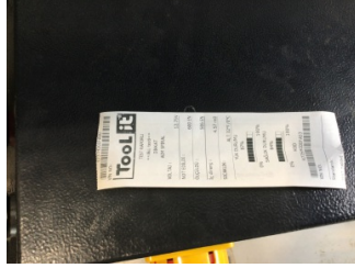
Elektrik donanımı/Pano, Akü > Test Sonucu
