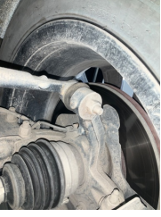
Ön aks, Denge çubuğu, bağlantı cubuğu sağ > Deforme Olmuş
