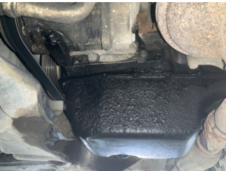
Motor, Motor > Yağ Kaçığı
