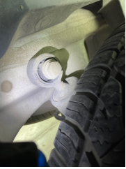
Arka aks, Süspansiyon, arka sol > Hasarlı
