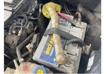
Elektrik donanımı/Pano, Akü > Standart Dışı Onarım
