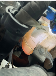
Motorsoğutması, Soğutma sıvısı > Eksik
