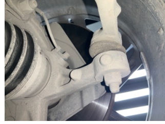
Ön aks, Denge çubuğu, bağlantı çubuğu sağ > Deforme Olmuş
