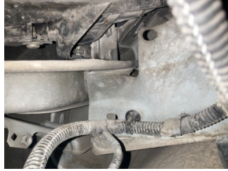
Kaporta, Sağ Kılıç Sacı > Standart Dışı Onarım
