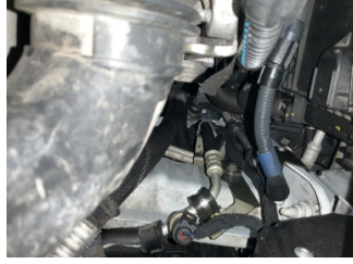
Kalorifer/Klima, Kalorifer/Klima > Sızdırıyor
