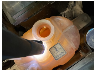
Motorsoğutması, Soğutma sıvısı > Eksik
