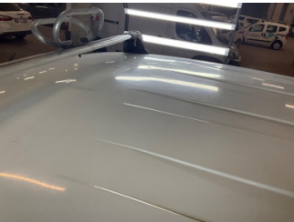
Tavan, Tavan > Hasarlı
