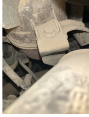
Motorsoğutması, Soğutma sıvısı > Eksik
