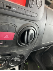
Kalorifer/Klima, Havalandırma ızgarası > Hasarlı
