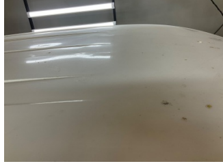
Tavan, Tavan > Hasarlı
