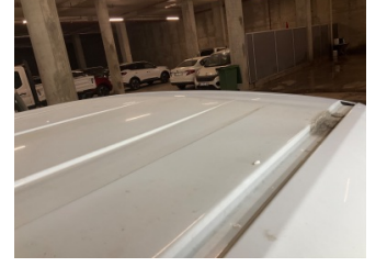
Tavan, Tavan > Hasarlı
