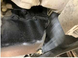
Motor, Motor > Yağ Kaçığı
