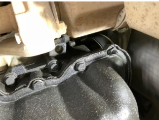
Motor, Motor > Yağ Kaçağı
