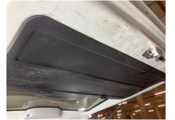
Döşemeler/Kapaklar, Döşemeler/Kapaklar > Çizik
