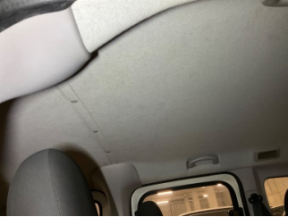
Döşemeler/Kapaklar, Döşemeler/Kapaklar > Kirlenmiş
