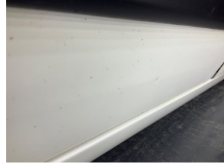
Kapı, sol ön, Kapı, sol ön > Ezik
