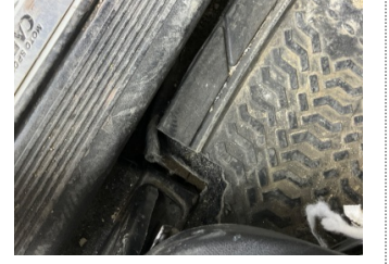
Döşemeler/Kapaklar, Döşemeler/Kapaklar > Hasarlı
