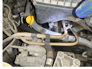
Motor, Motor > Yağ Kaçağı
