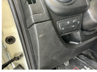
Döşemeler/Kapaklar, Döşemeler/Kapaklar > Sabitlemesi Hatalı
