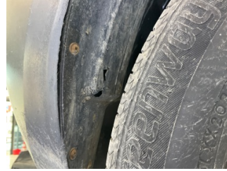
Çamurluk, sağ arka, Davlumbaz > Hasarlı
