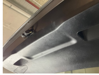
Döşemeler/Kapaklar, Döşemeler/Kapaklar > Kirlenmiş
