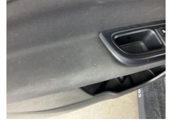
Döşemeler/Kapaklar, Döşemeler/Kapaklar > Yakıcı Madde Ile Zarar Görmüş
