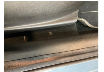
Döşemeler/Kapaklar, Döşemeler/Kapaklar > Yakıcı Madde Ile Zarar Görmüş
