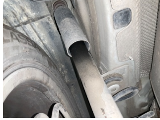
Arka aks, Amortisör, arka > Yağ Kaçağı
