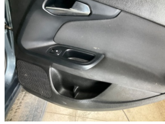
Döşemeler/Kapaklar, Döşemeler/Kapaklar > Deforme Olmuş
