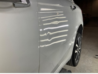
Kapı, sol arka, Kapı, sol arka > Hasarlı
