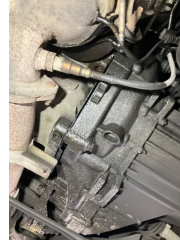
Şanzıman, Şanzıman > Yağ Kaçağı
