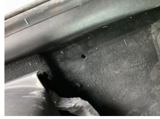
Döşemeler/Kapaklar, Döşemeler/Kapaklar > Yakıcı Madde ile Zarar Görmüş
