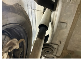
Arka aks, Amortisör körüğü, sol > Yağ Kaçağı
