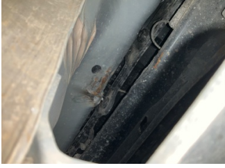
Arka bölüm, Arka sac/panel > Standart Dışı Onarım
