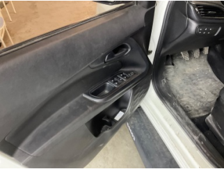
Döşemeler/Kapaklar, Döşemeler/Kapaklar > Deforme Olmuş
