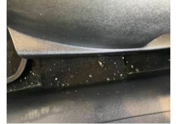
Döşemeler/Kapaklar, Döşemeler/Kapaklar > Yakıcı Madde ile Zarar Görmüş
