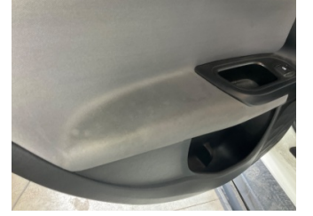
Döşemeler/Kapaklar, Döşemeler/Kapaklar > Deforme Olmuş
