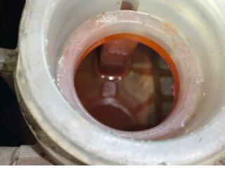
Motorsoğutması, Soğutma sıvısı > Kirlenmiş
