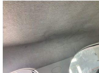
Döşemeler/Kapaklar, Döşemeler/Kapaklar > Kirlenmiş
