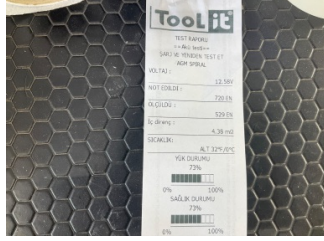
Elektrik donanımı/Pano, Akü > Test Sonucu
